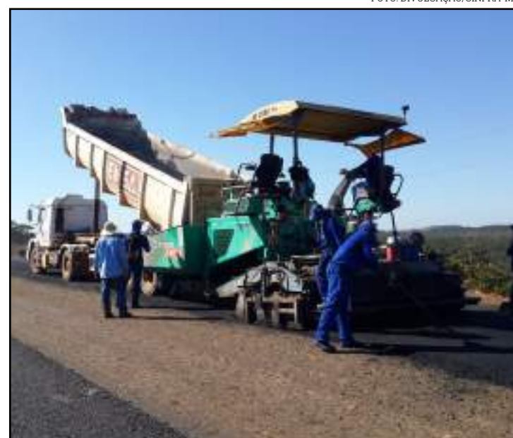
Operários e maquinários em movimento nas obras da rodovia
