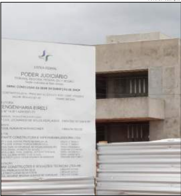
Obra está em construção próximo à UFMT
