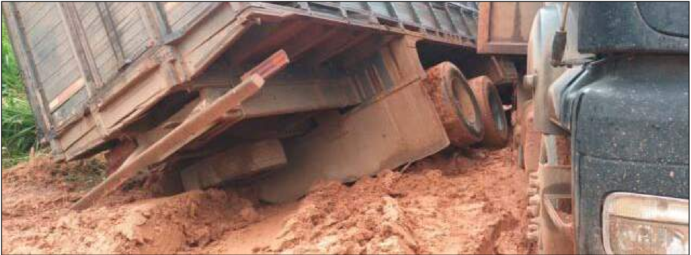
Estrada aberta há 4 décadas ainda não tem asfalto
