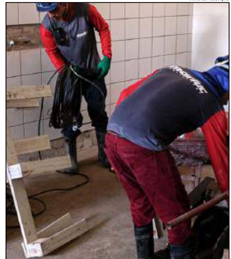
Obras de ampliação do HR visam oferecer unidade decente à população
