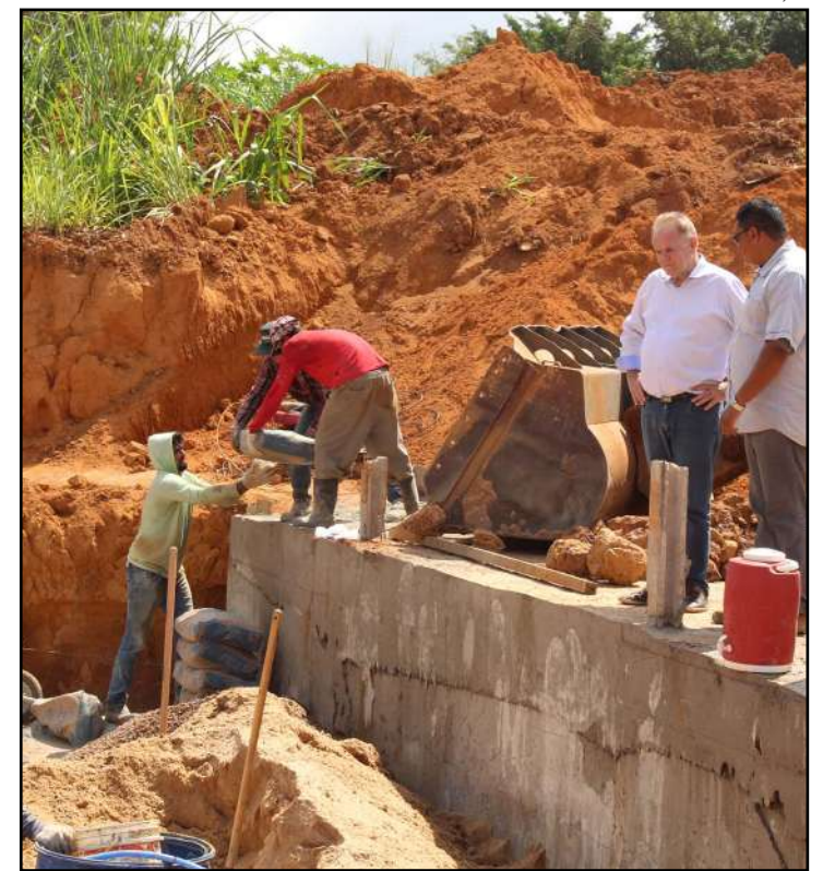
Obras de contenção da erosão já são realizadas em Tapurah
