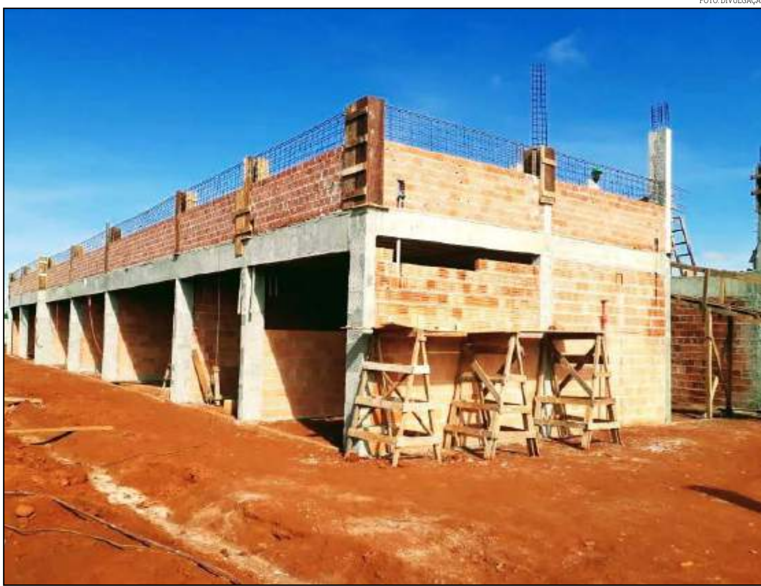
Prédio principal avança na construção
