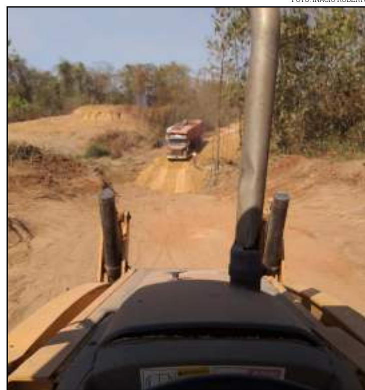
A obra de desvio foi concluída sábado
