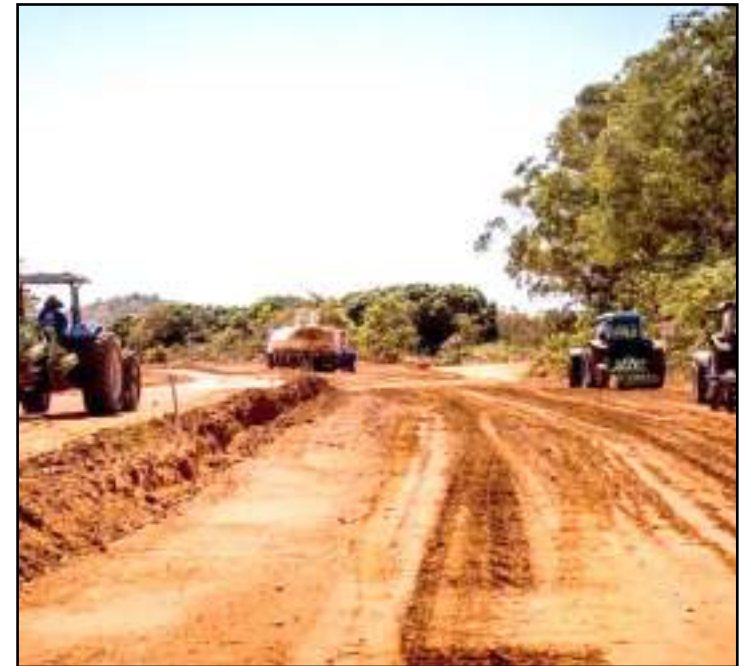
Serão asfaltados 34,46 km da MT-485
