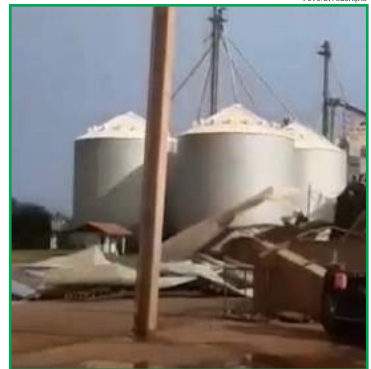
Tempestade destruiu barracão, derrubando destroços do telhado
