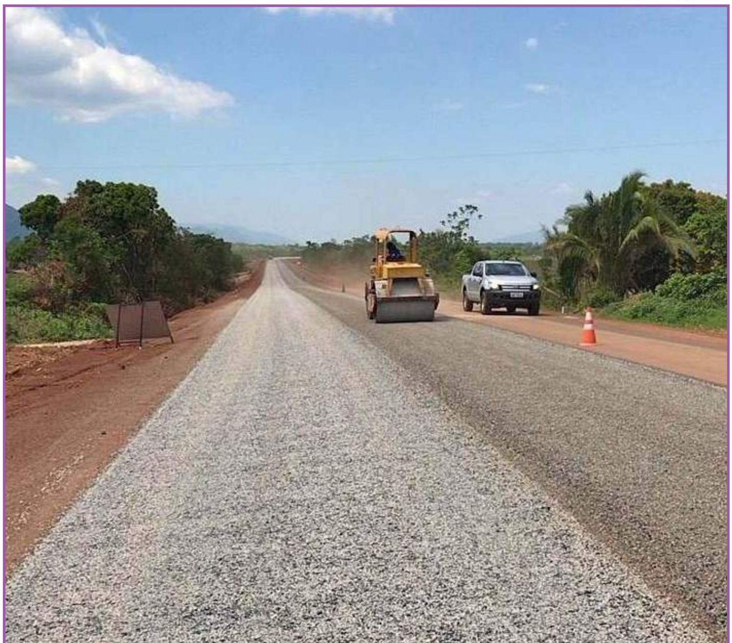
Concluído asfaltamento de trecho; obras aceleradas na MT-343
