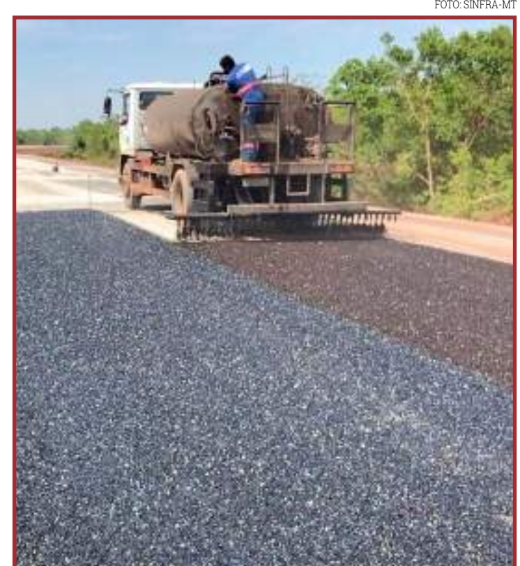
Ao todo serão pavimentados 120 km da MT-343
