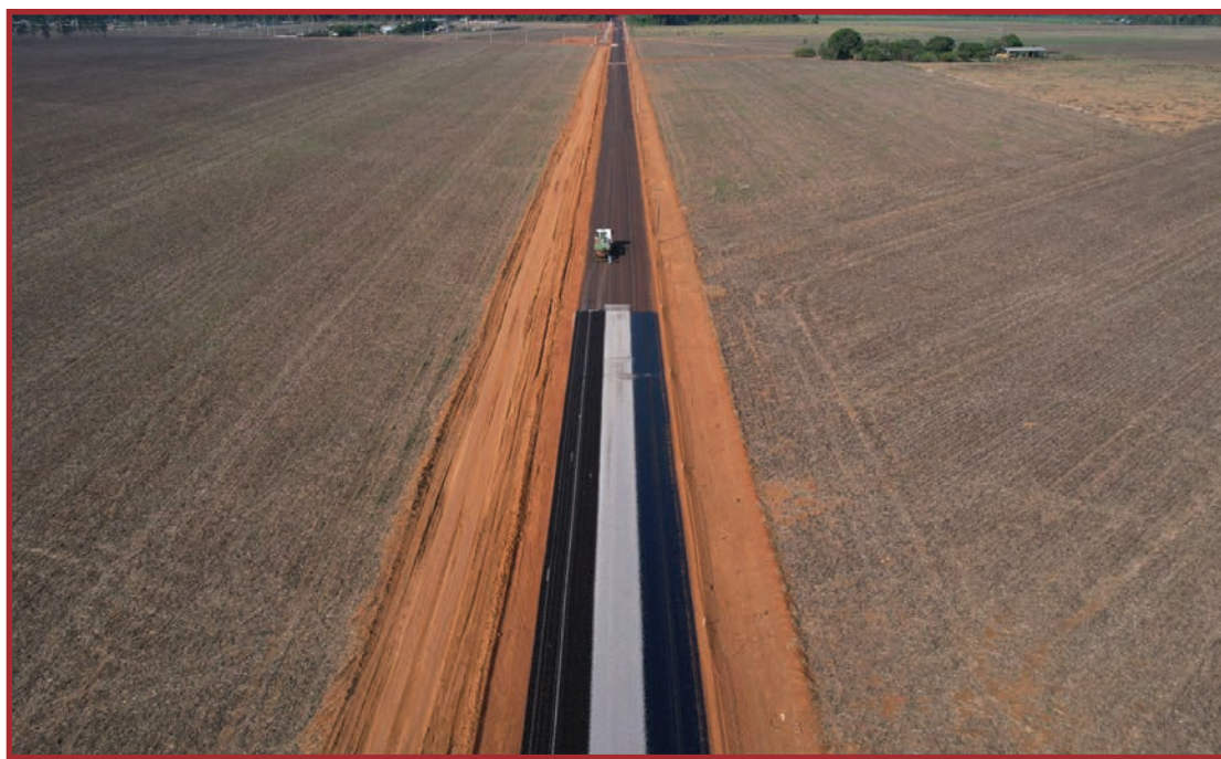
Conclusão da obra deve ser ainda este mês
