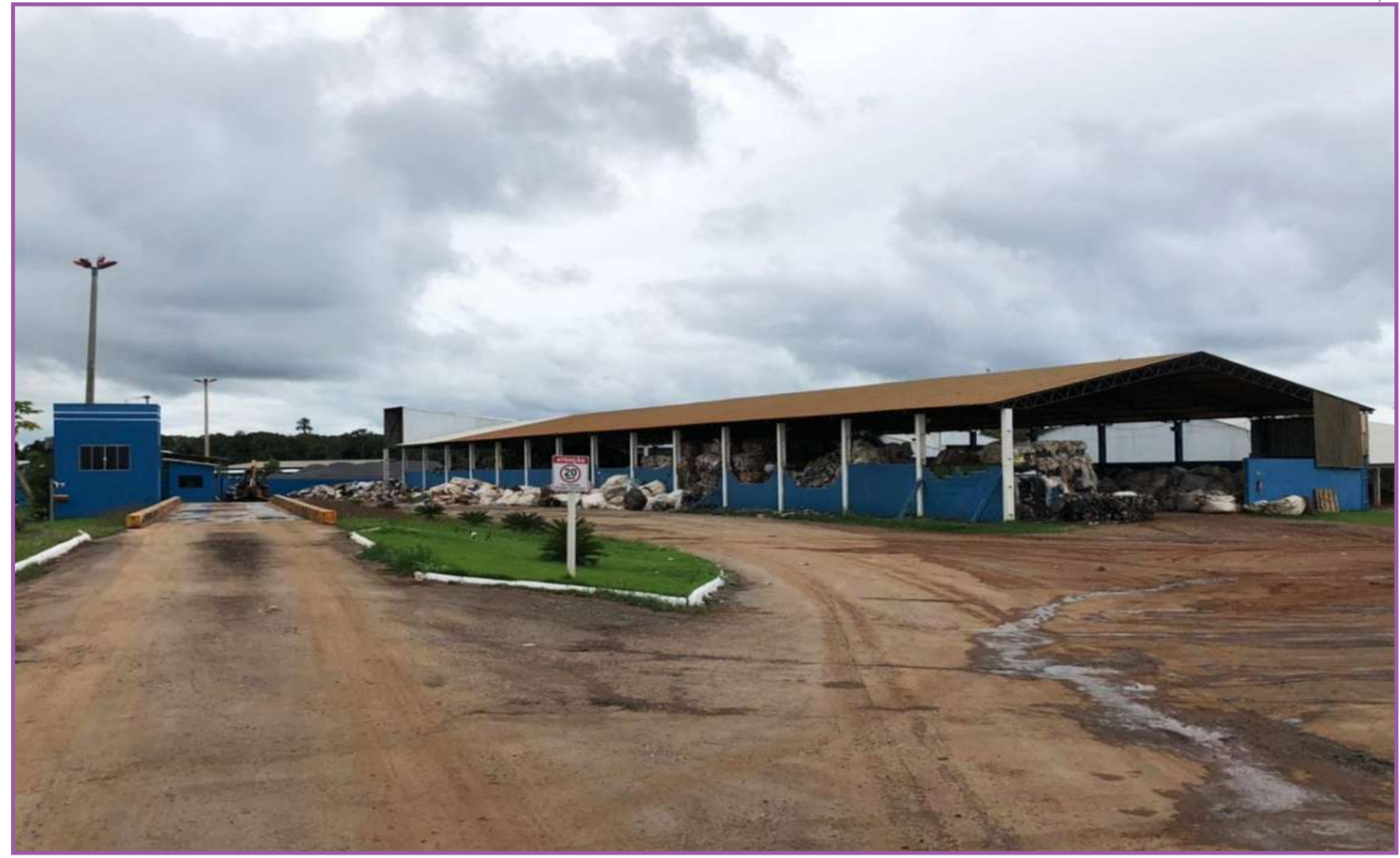
Autarquia fez a pavimentação com asfalto na rampa de transbordo do lixo úmido, pintura nos muros e jardinagem na área verde
