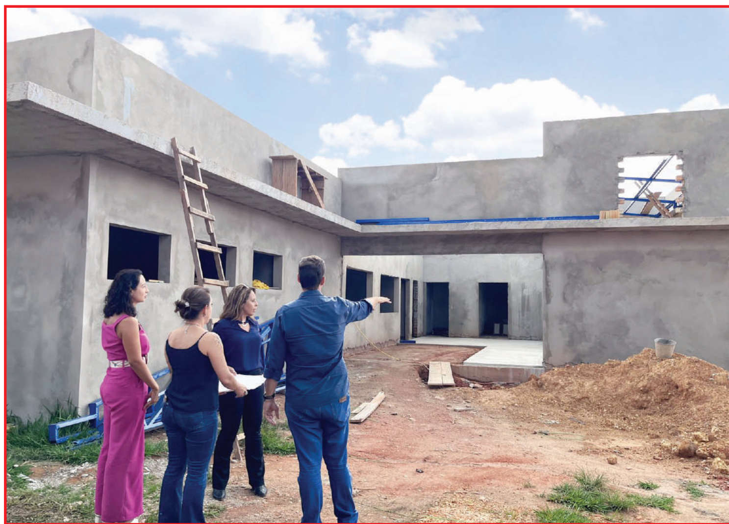
Vistoria na obra de construção da nova sede da Sema de Alta Floresta
