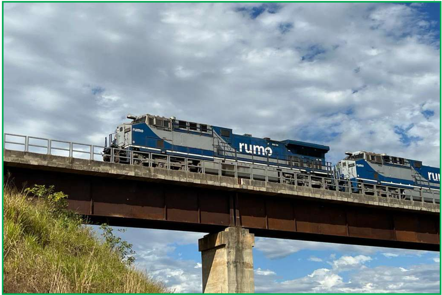
Liberação se refere ao terceiro trecho da obra
