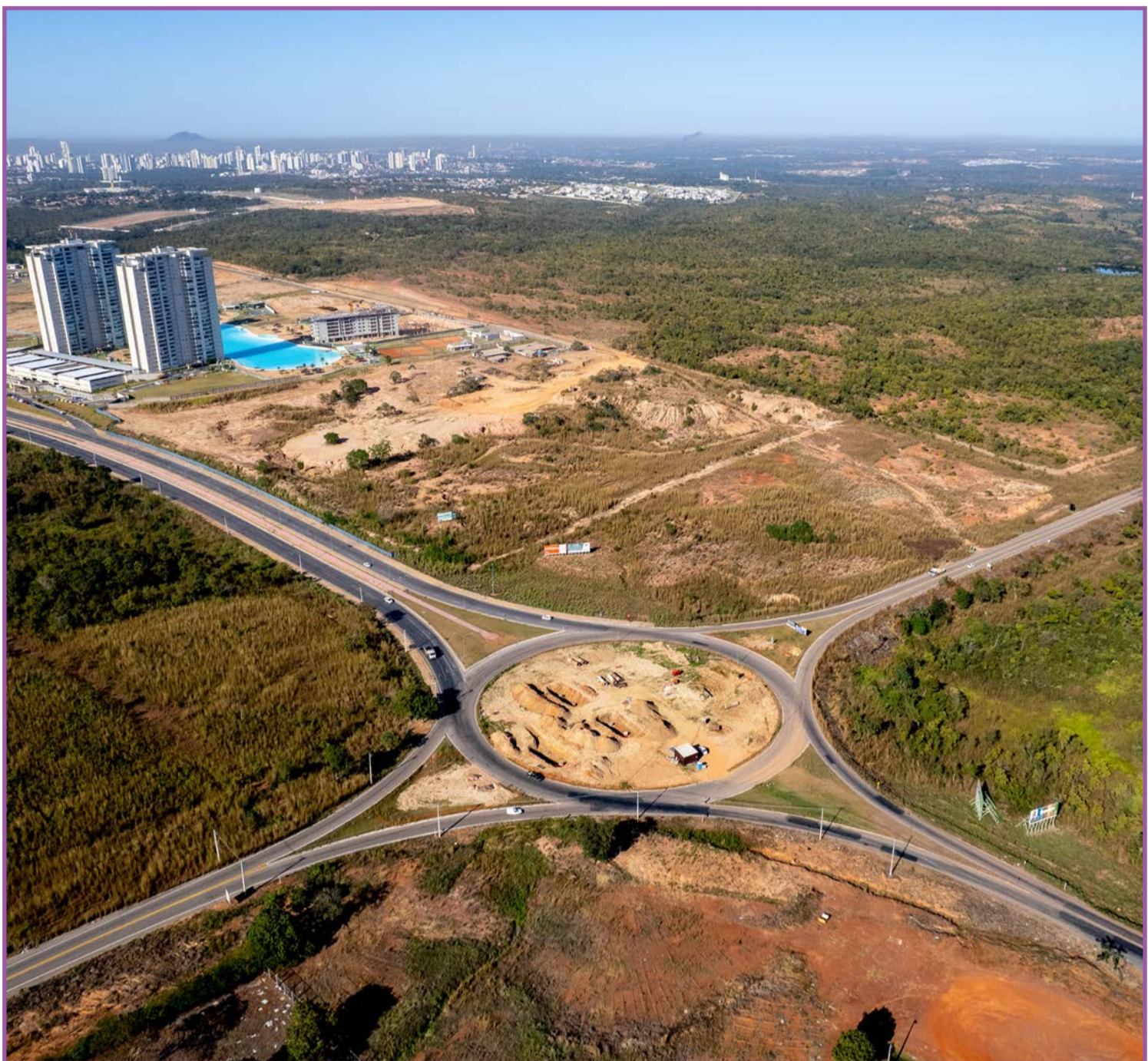
As obras de construção do Rodoanel de Cuiabá e Várzea Grande
