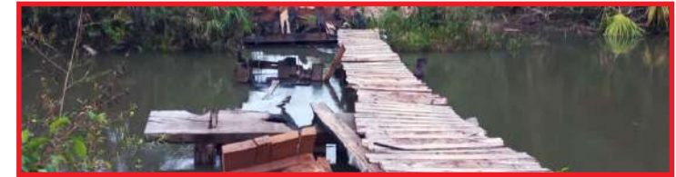
Ponte na Estrada Judith é apenas um improviso
