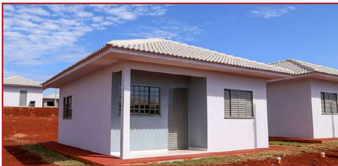
Construção de casas populares em 43 municípios
