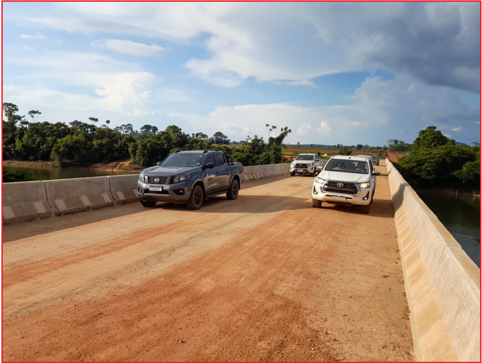
Ponte sobre o Rio dos Peixes em Juara
