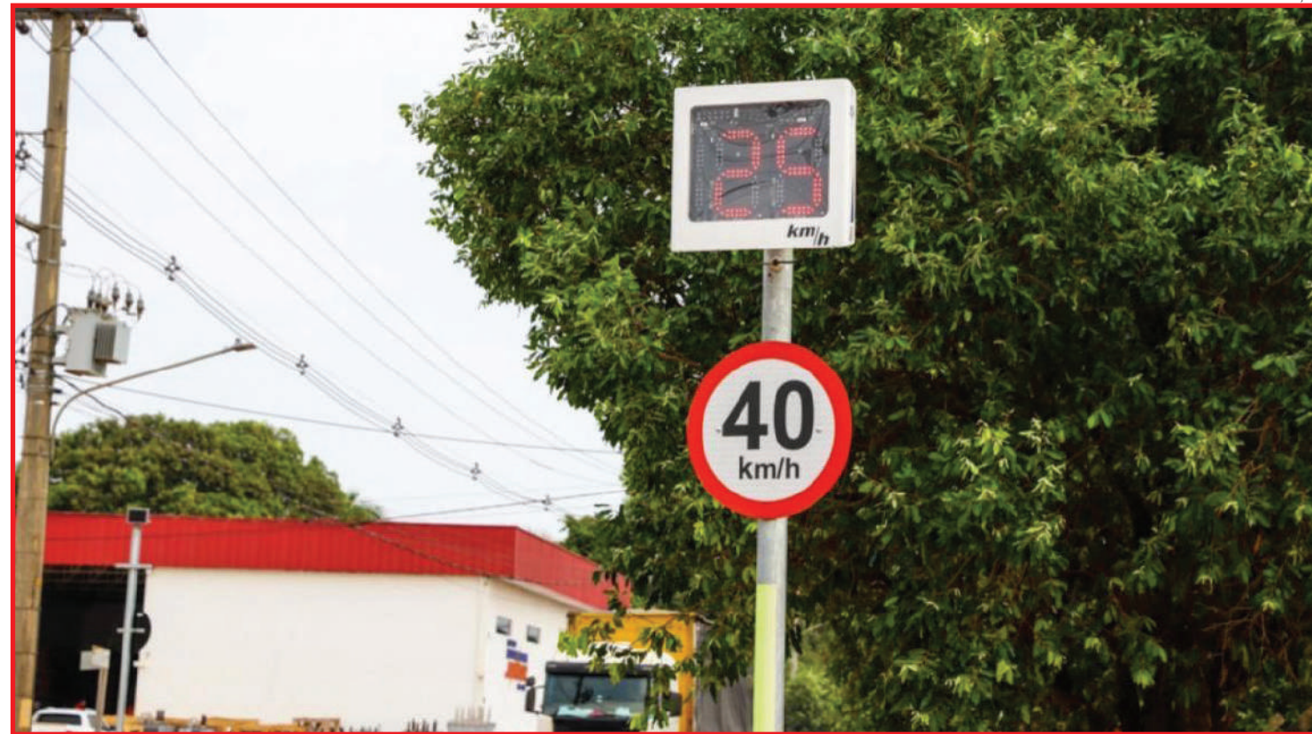
Dispositivos de fiscalização foram instalados em oito pontos de Sorriso
