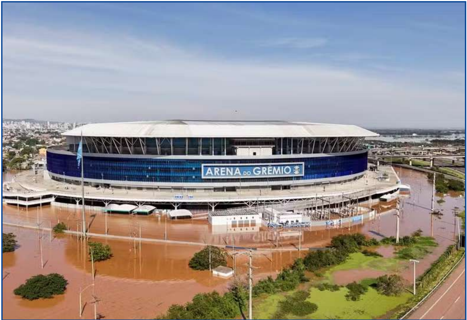
Arena do Grêmio completamente alagada pelas chuvas em Porto Alegre
