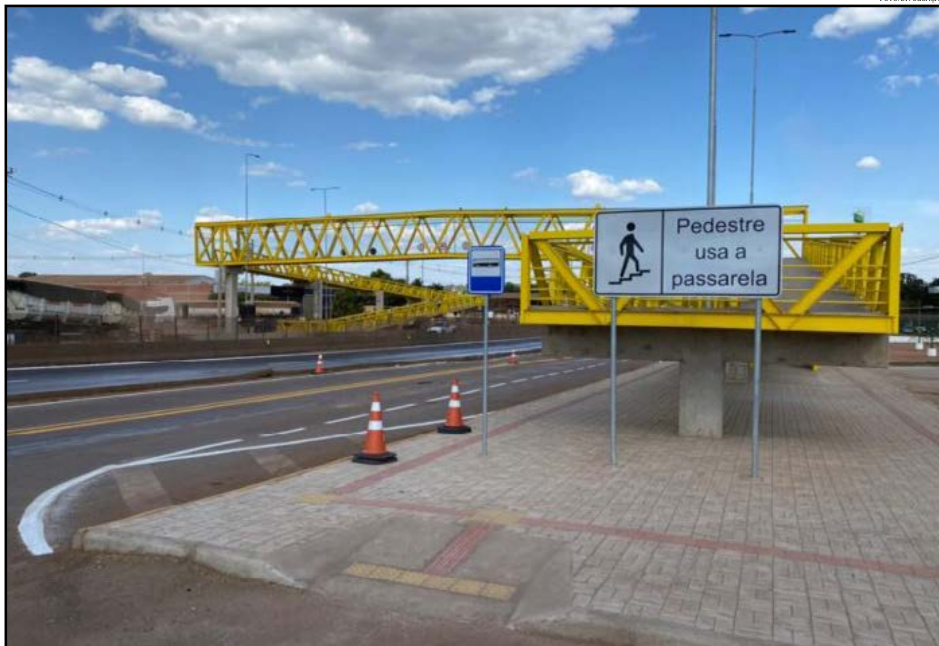
Construção das três passarelas para pedestres iniciou em maio
