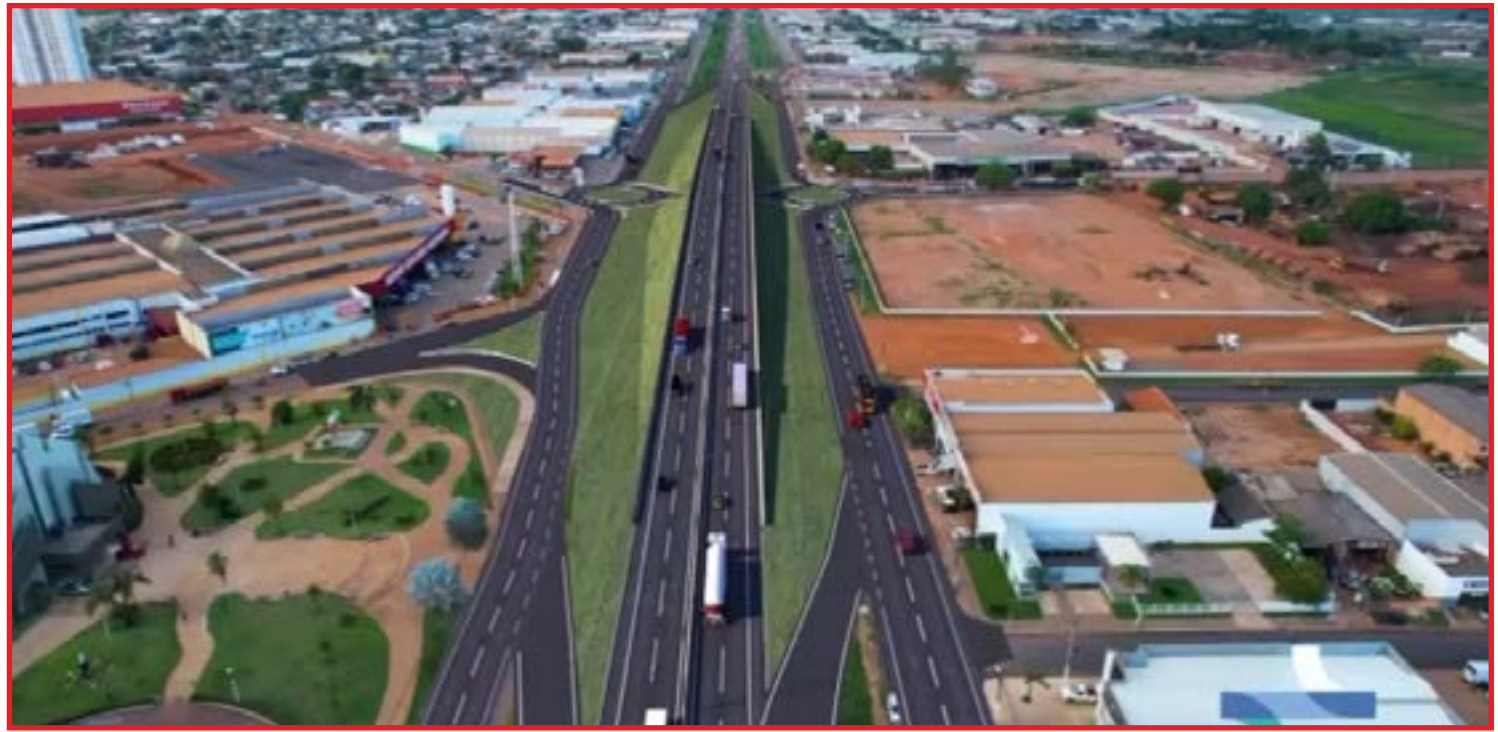
Ordem de serviço para duplicar BR e construir viadutos
