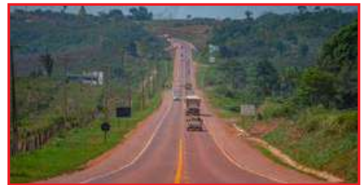
Obras na BR-163 em MT e PA
