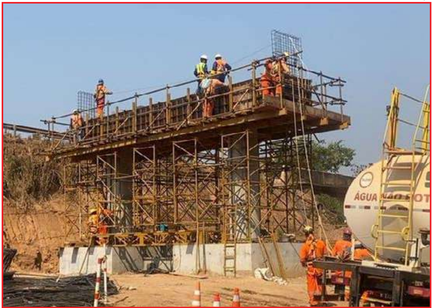
As obras tiveram início em julho de 2023
