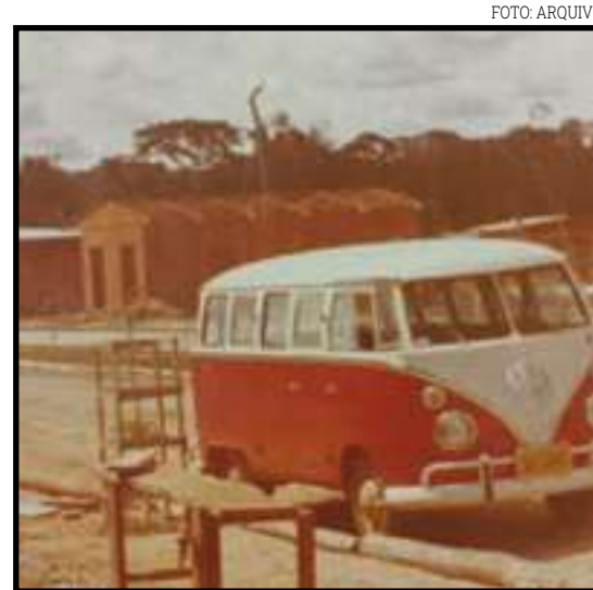
Ruas e casas sendo construídas
