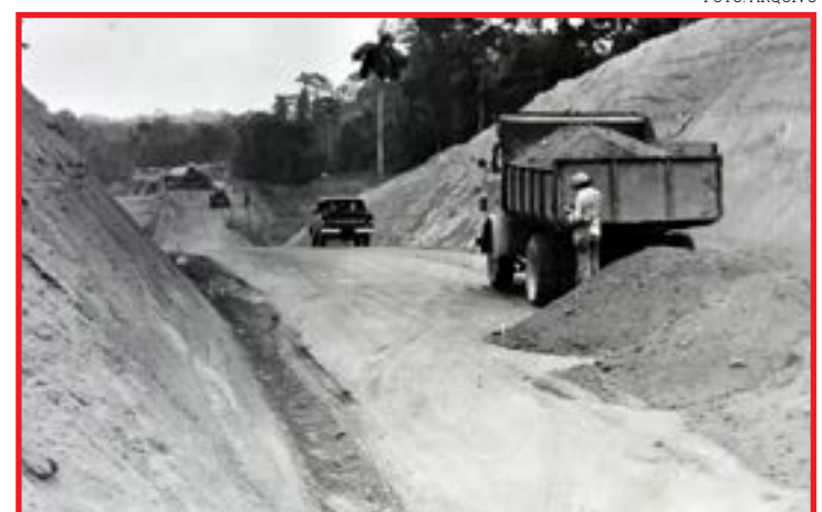
Registro das obras de construção da rodovia
