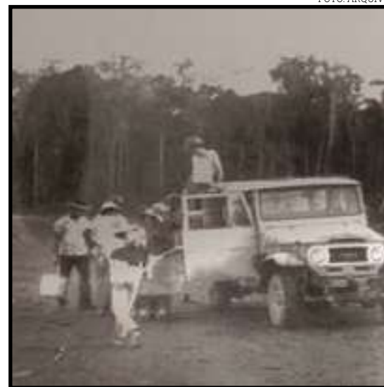
Primeiras ruas sendo abertas
