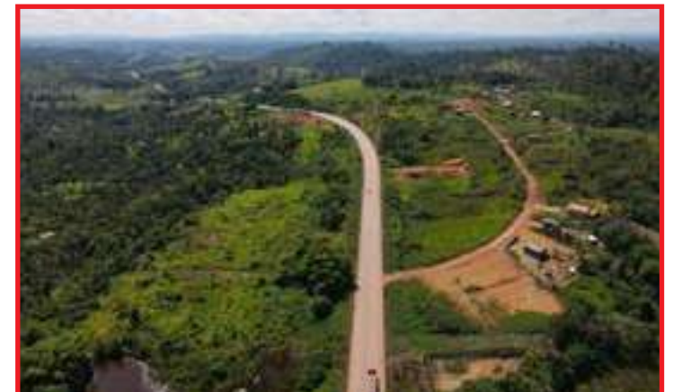
Obras nas BRs 163 e 230
