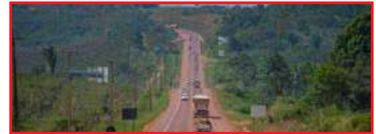
Obras nas rodovias de MT e PA
