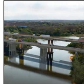
Com 255 metros de extensão, a ponte sobre o Rio Cuiabá na Rodovia dos Imigrantes (BR-070), entre a capital e Várzea Grande, está em fase de duplicação e a Nova Rota do Oeste vai utilizar o método construtivo de balanço sucessivo, uma técnica que aos olhos desavisados "desafia a gravidade".
