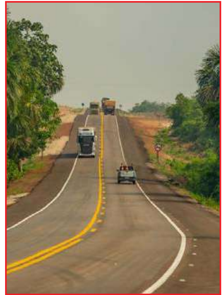
Manutenção em rodovias federais
