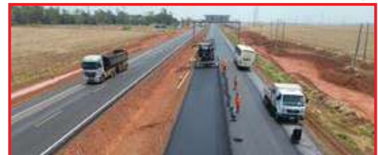
Alteração vai permitir a recuperação da pista existente em 11 km da rodovia
