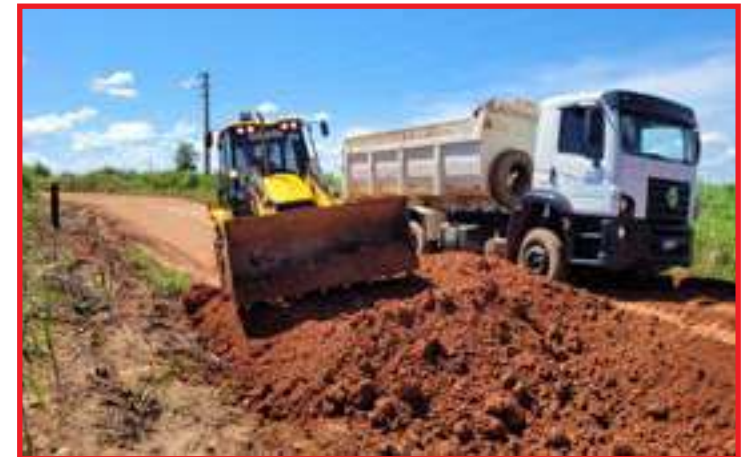
Equipes trabalham na estrada de acesso ao Assentamento Jonas Pinheiro
