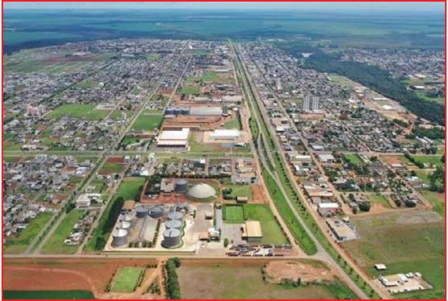
Também haverá construção de Pontos de Parada e Descanso (PPD)
