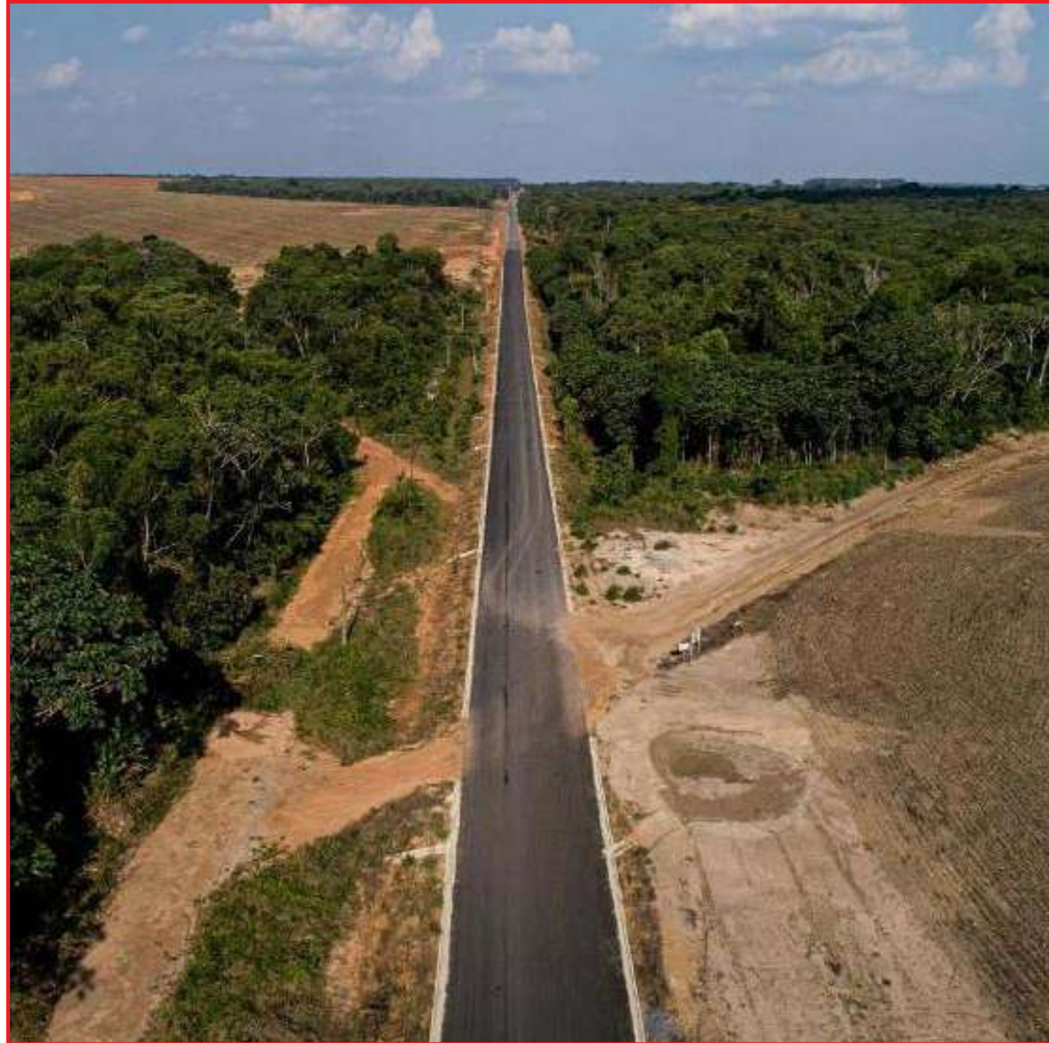
Estado já asfaltou 112 km de importante ligação da região norte mato-grossense
