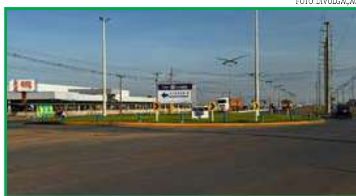
Implementação da via se tornou essencial para garantir a eficiência no trânsito
