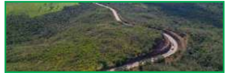
Obras ao longo desta obra
