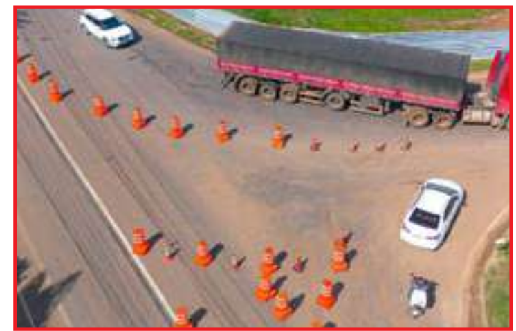
Obras na BR-163 em Sinop
