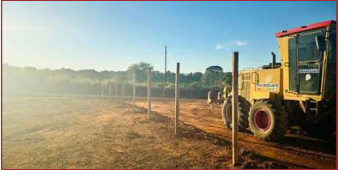
Terreno no Verdes Campos está passando por terraplanagem
