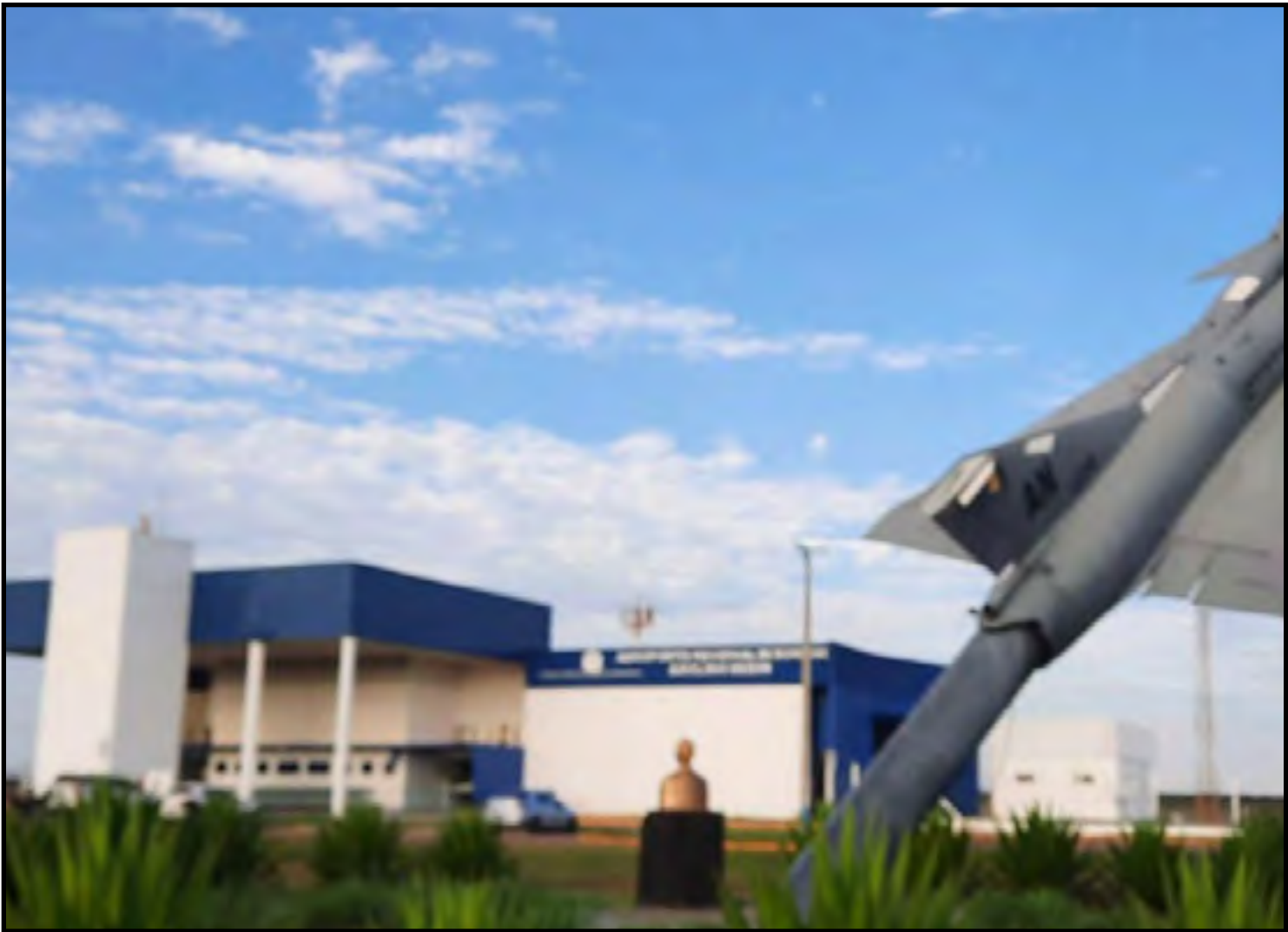
Terminal de 6 mil m² será construído
