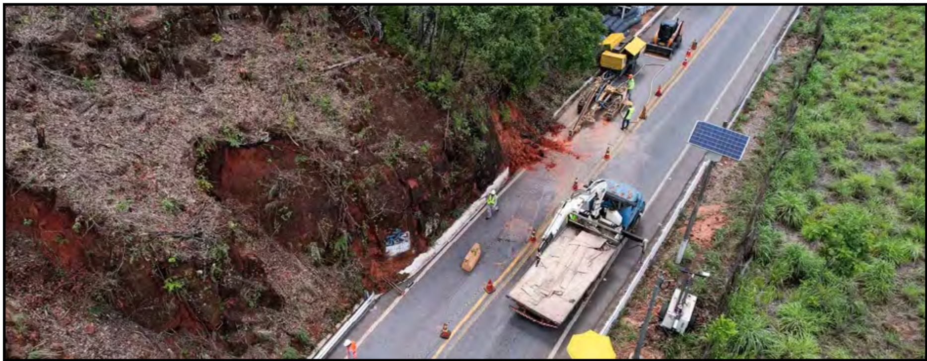
Obras de retaludamento na região do Portão do Inferno
