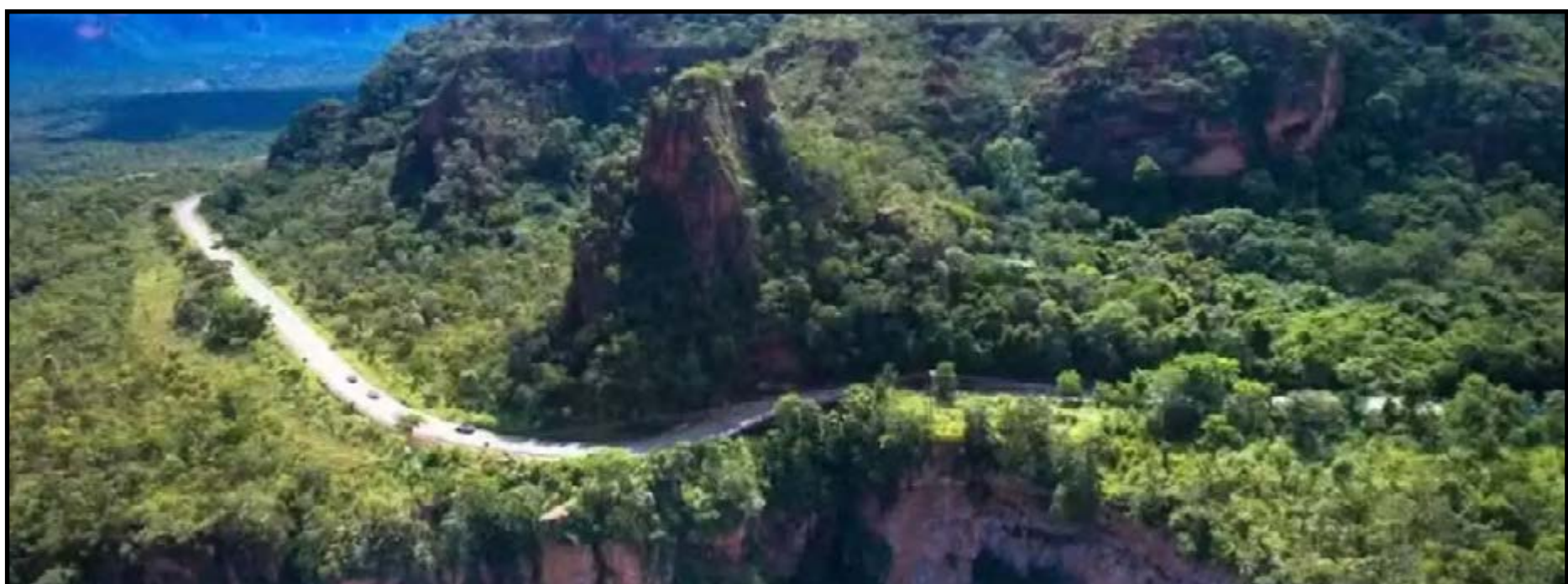
Obras de retaludamento na região do Portão do Inferno
