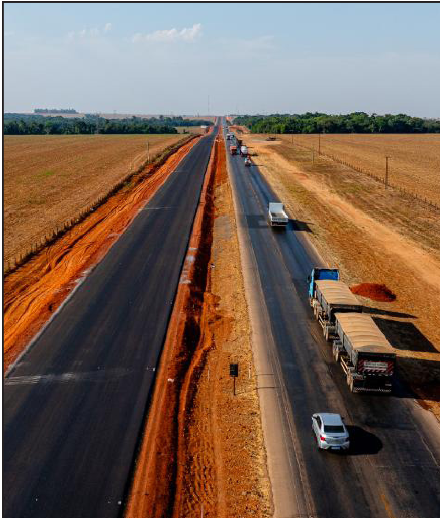
Nova Rota aplicou R$ 2,1 bilhões em obras e melhorias em 2025
