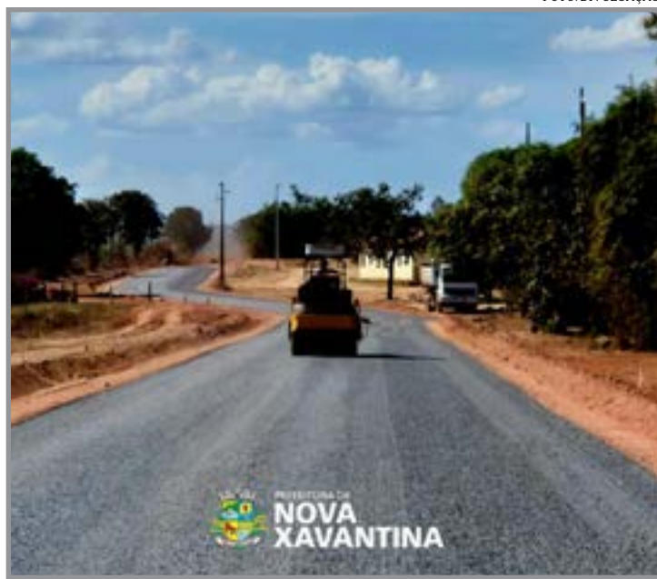
Pavimentação asfáltica no PA Piau
