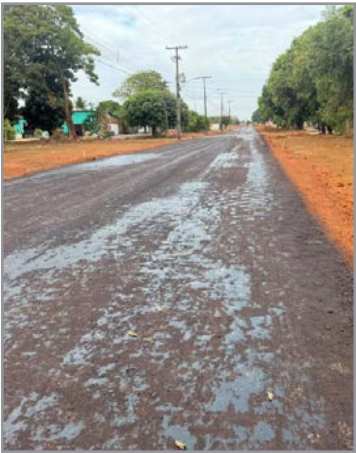
Via recebe imprimação antes da aplicação do asfalto
