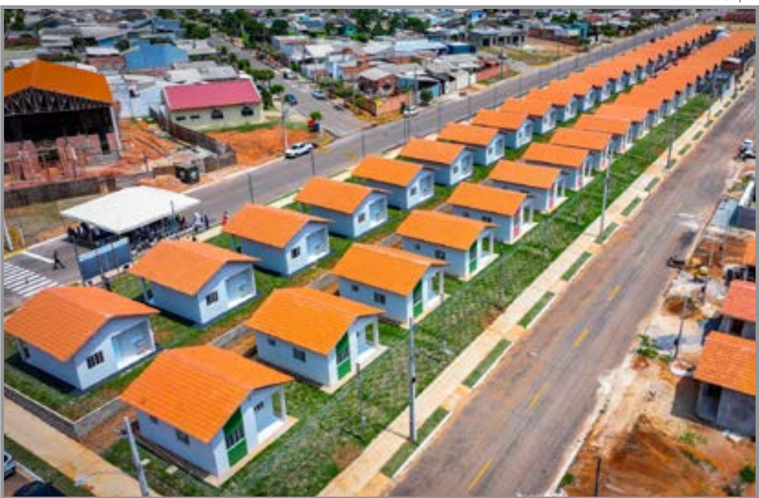
Construção entre 850 e 880 unidades habitacionais verticais de interesse social
