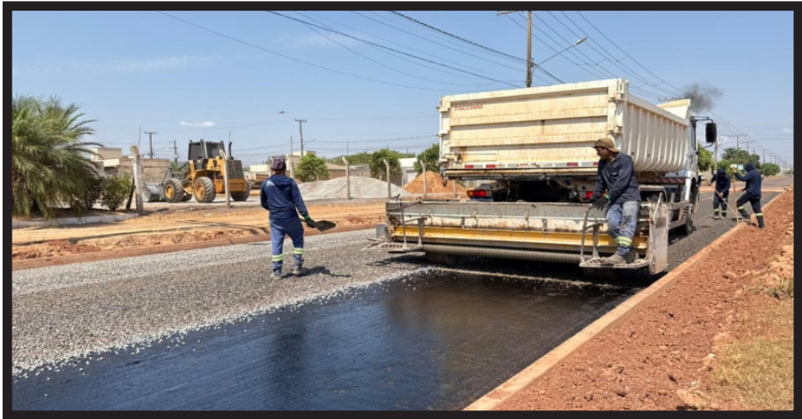
A Prefeitura de Sinop avançou para mais uma etapa do maior pacote de pavimentação asfáltica em execução no município. A Estrada Claudete/Avenida Joaquim Socreppa começou a receber a aplicação da camada de asfalto, dando sequência aos serviços de preparação da via e aproximando a obra de sua conclusão. A intervenção contempla uma área de aproximadamente 32 mil m². A pavimentação representa um importante avanço para a mobilidade urbana da região, contribuindo para melhorar o fluxo de veículos, ampliar a segurança viária e oferecer melhores condições de trafegabilidade em uma área de grande circulação. Antes da aplicação do asfalto, as equipes concluíram os serviços de imprimação, etapa responsável pela impermeabilização e preparação da base para receber a pavimentação.
