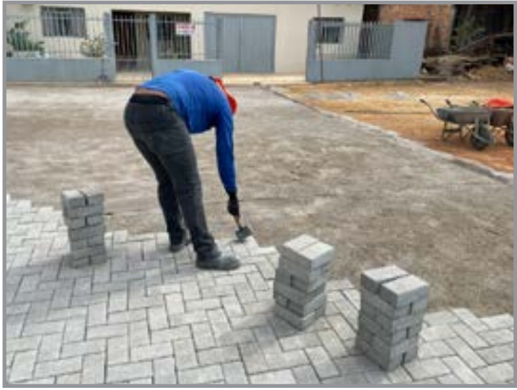
Calçamento na Avenida Central
