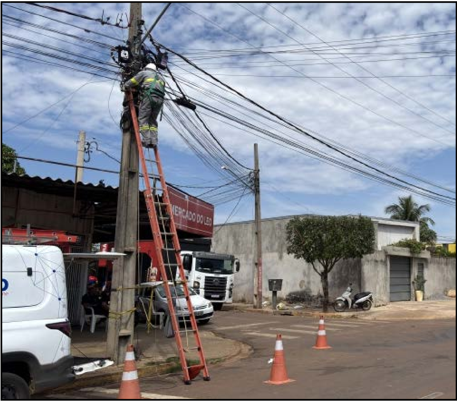
Retirada de fiação em desuso e excedente em Sinop
