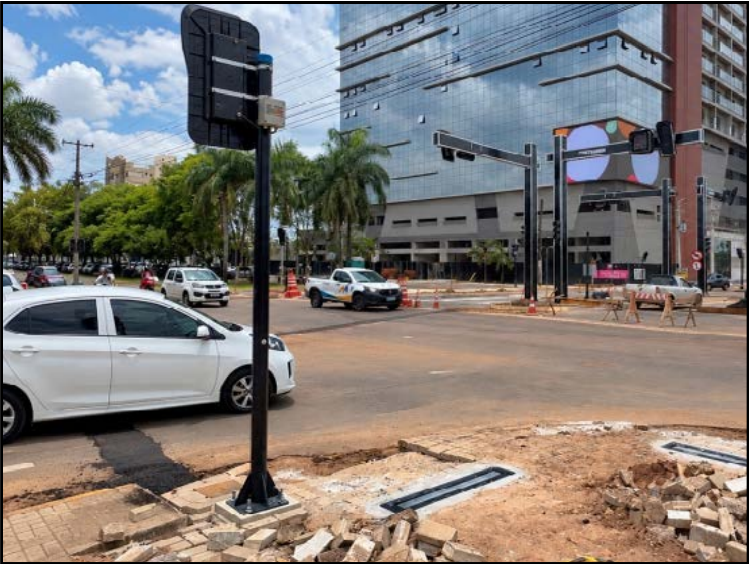
Modernização da infraestrutura de trânsito do município
