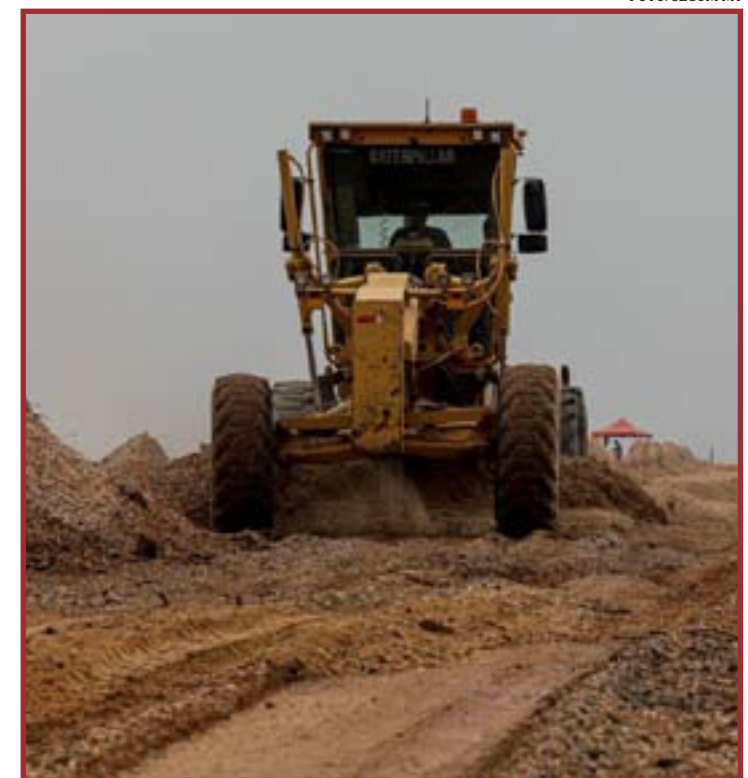
Os serviços serão no trecho do entroncamento da BR-158 com da MT-437
