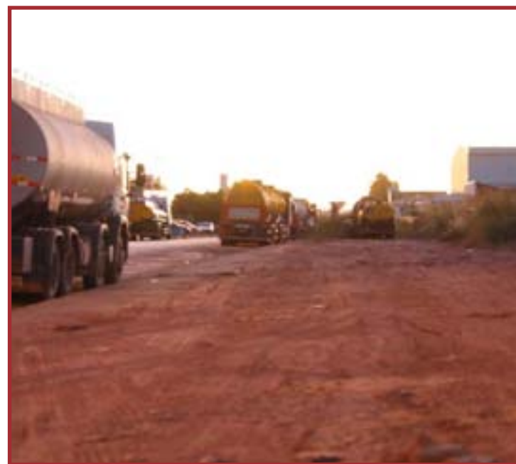
Os serviços de infraestrutura serão realizados em 23 ruas e seis avenidas
