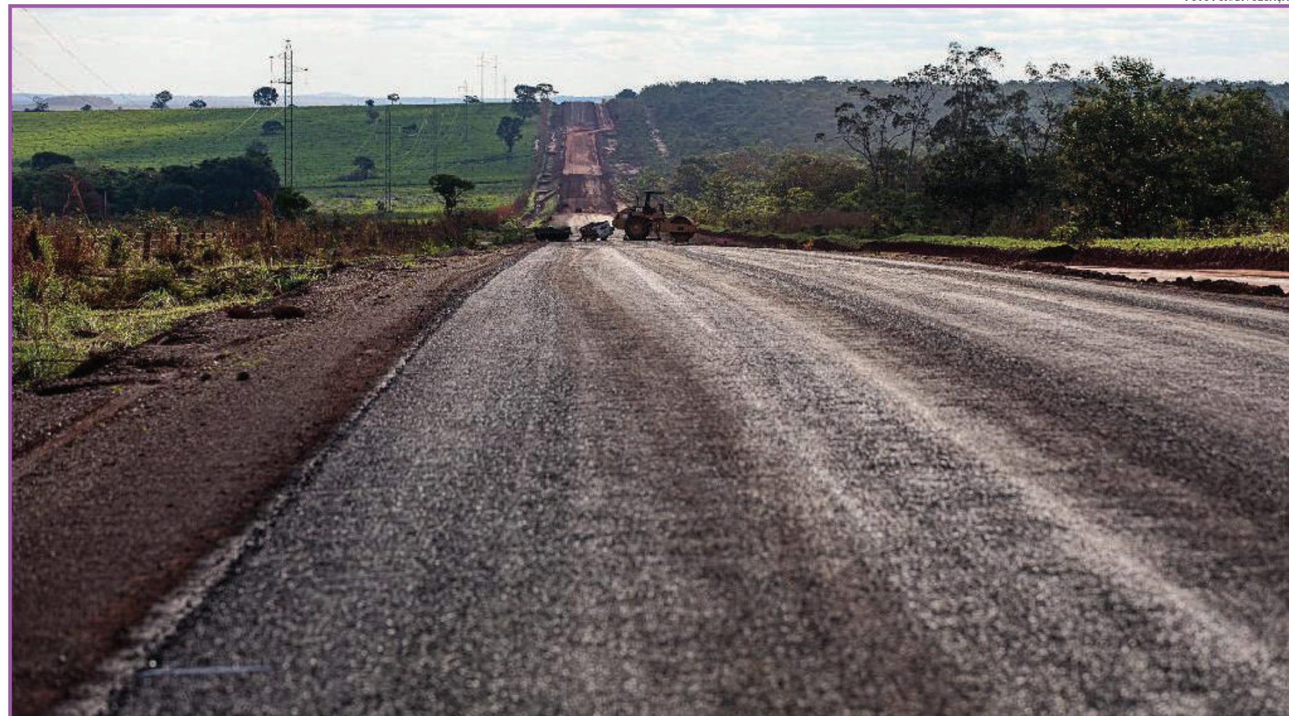
Obras de pavimentação da MT-100 em Novembro de 2021
