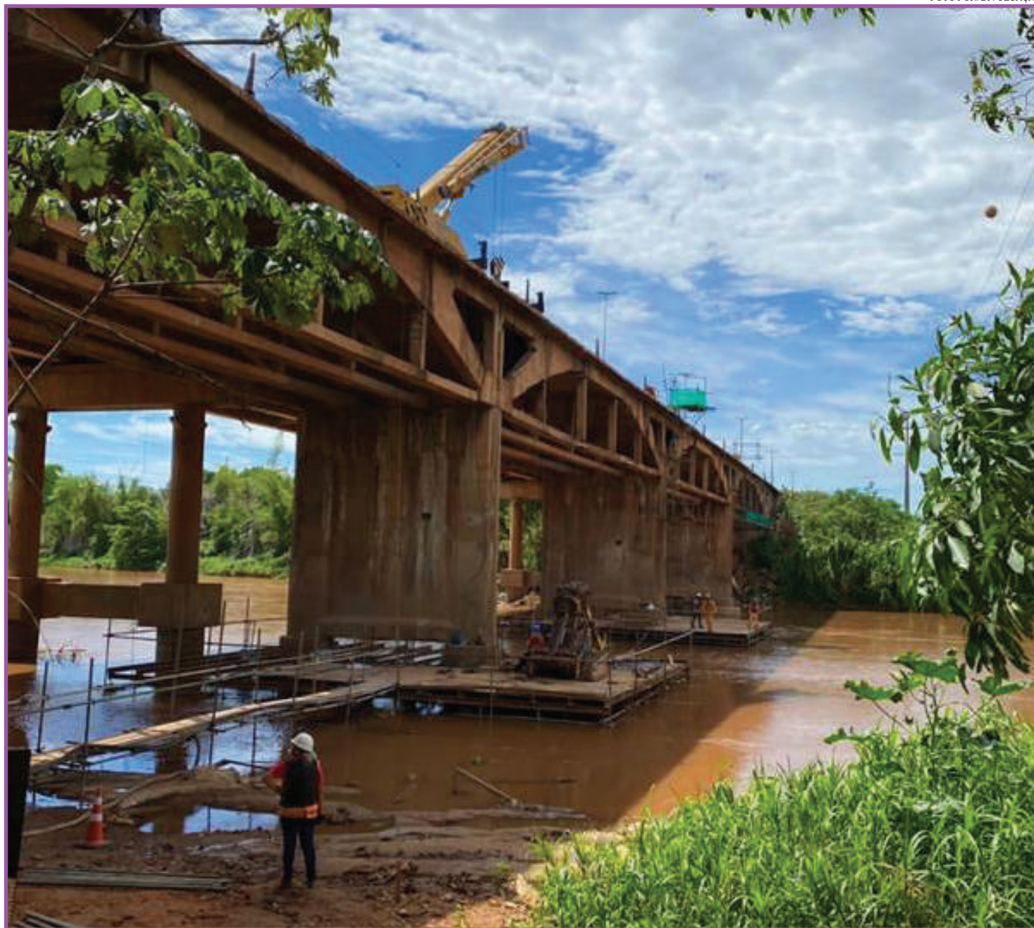
Rota do Oeste providenciou a manutenção e os serviços de limpeza em 76 pontes
