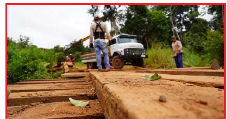
Ponte na Estrada do Galo é muito usada para escoar produção agrícola de fazendas no entorno
